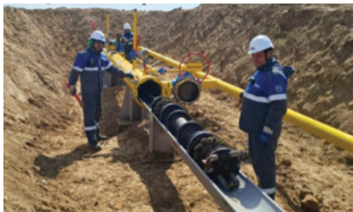
ОБЕСПЕЧИВАЯ НАДЕЖНОСТЬ ГАЗОПРОВОДА Проведены работы по внутритрубному диагностированию газопровода-отвода Стр. 2
