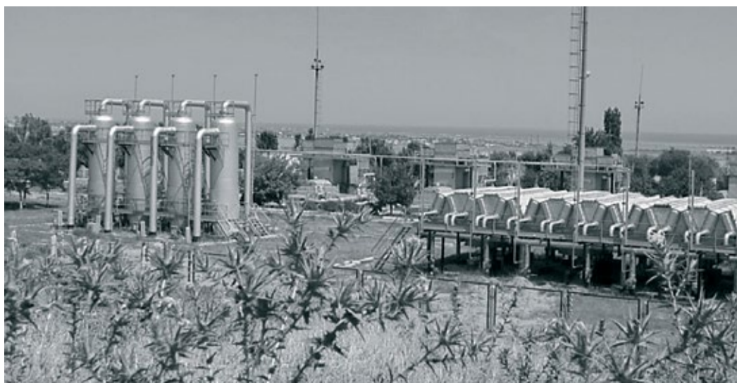
Компрессорная станция «Избербаш»
